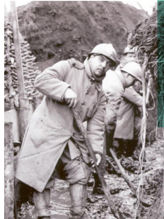
Travail dans les tranchées.
